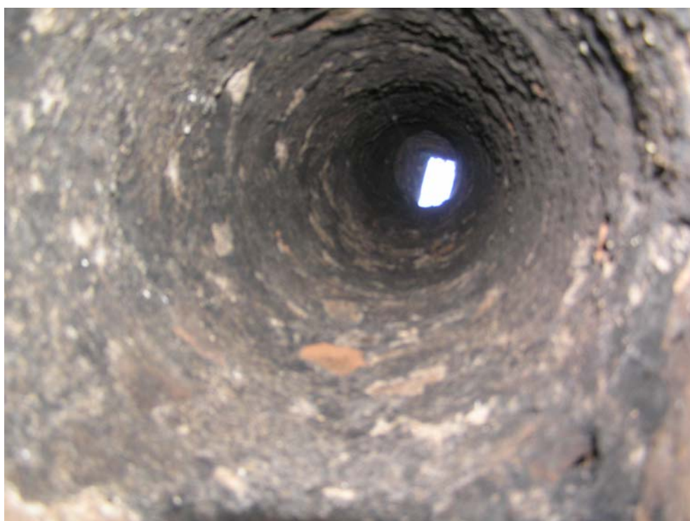
Foto 12: Komín 3, podkroví, pohled jedním z průduchů směrem vzhůru, průduchy se v horní části komína spojují v jeden průduch
