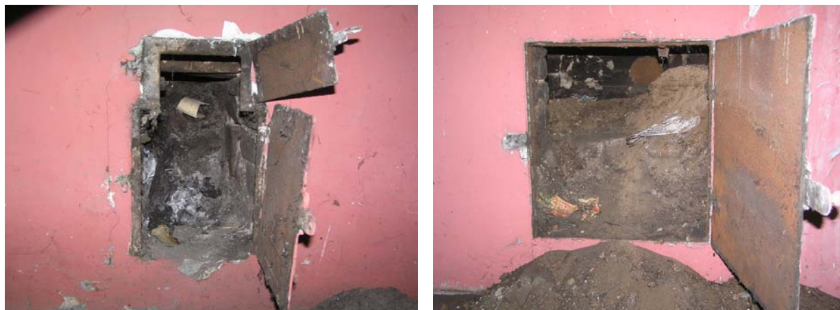
Foto 5 a 6: Komín 1, 1. patro, vymetací otvor 1 (vlevo) a 2 (vpravo)
