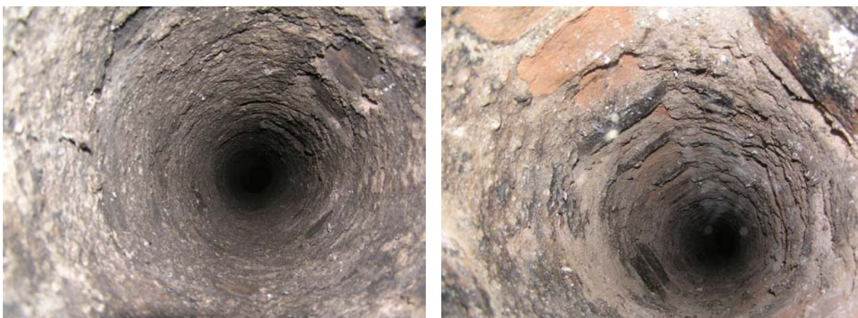
Foto 10 a 11: Komín 3, podkroví, pohled do průduchů revizními otvory směrem dolů
